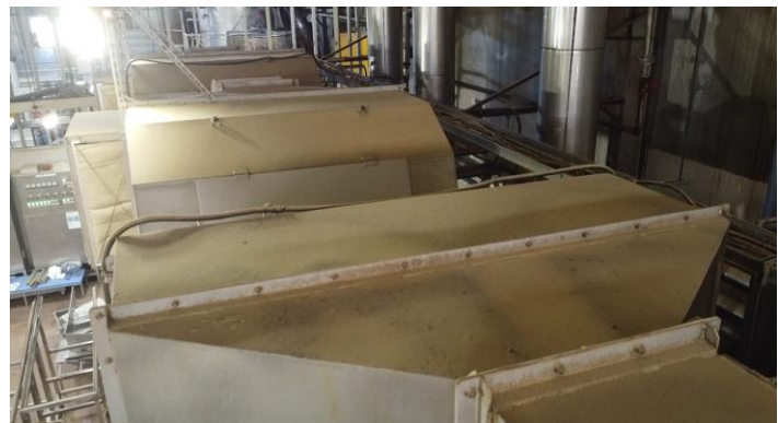
<ドローン目線でのバンド乾燥機上部>
