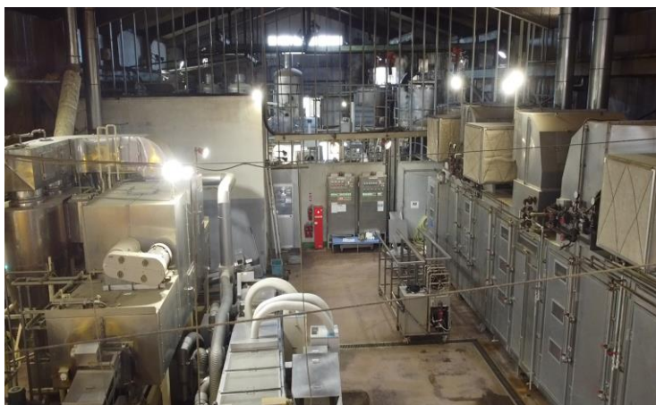
『ドローン目線で見た工場内全体風景』
